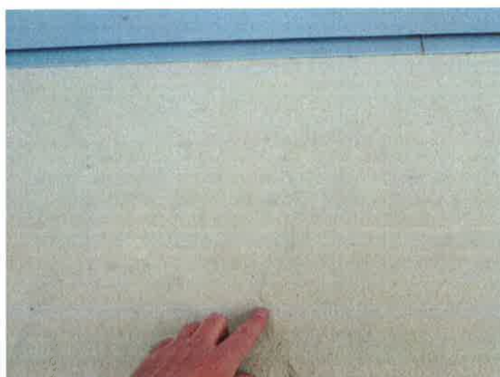
Foto nr. 21: G 6. I balkonggulvet er det flere tversgående riss, noen med bom i betongen som vist her.
